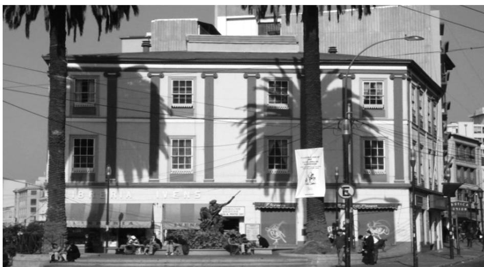
exteriormente con morteros de cemento e interiormente en yeso con elementos aglomerantes de tela o crin de caballo o malla de fierro sobre madera, con sujeciones metálicas empotradas a los muros.
