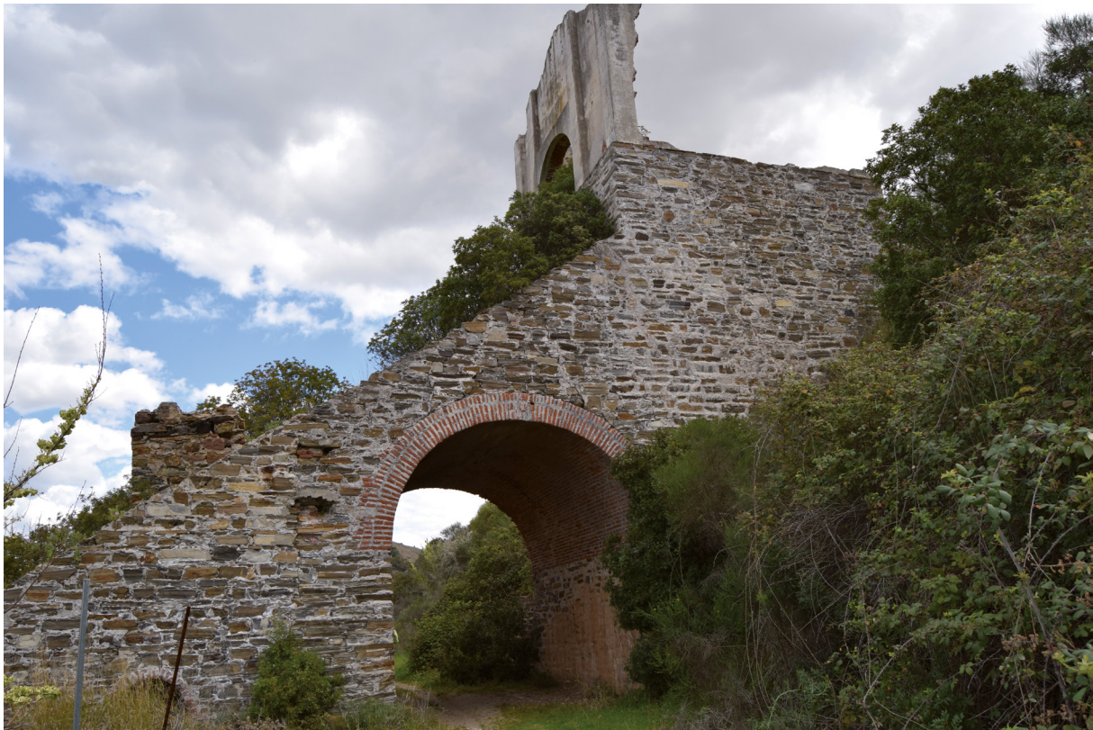
FIGURA 8. POZO MEJORADA DE LA MINA LA ROSA
