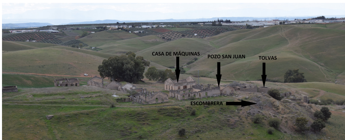
FIGURA 7. POZO SAN JUAN E INSTALACIONES EN EL POBLADO MINERO DE LA ROSA
