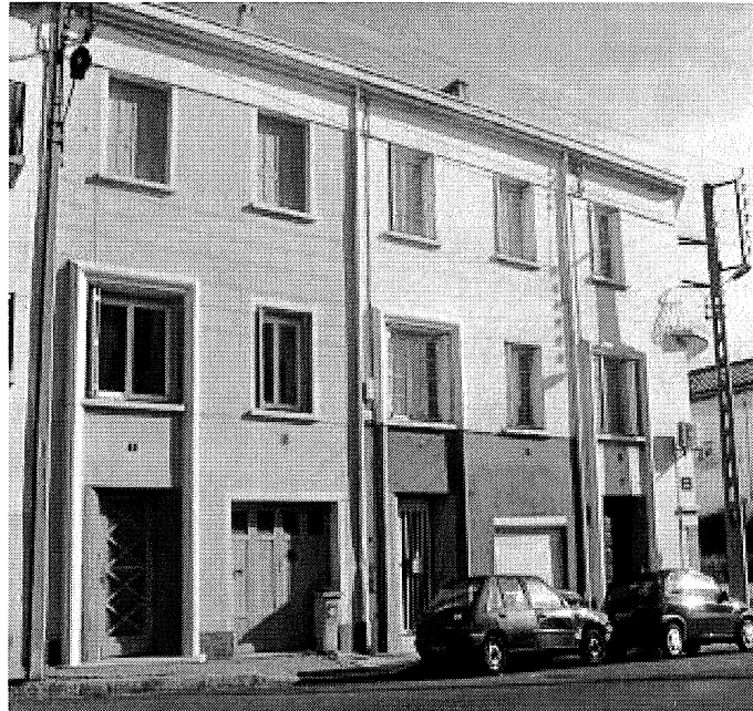
FOTO 9. EDIFICIOS DE CASAS DEL BARRIO MAILLOLES
