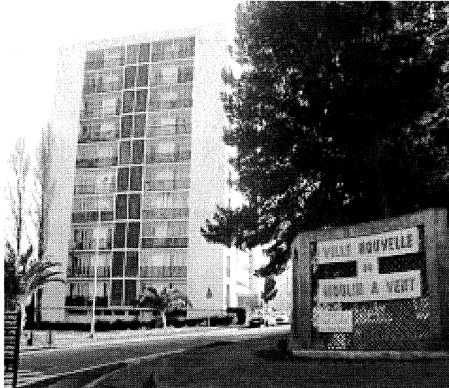
A la izquierda, uno de los primeros bloques construidos en los años 60.
