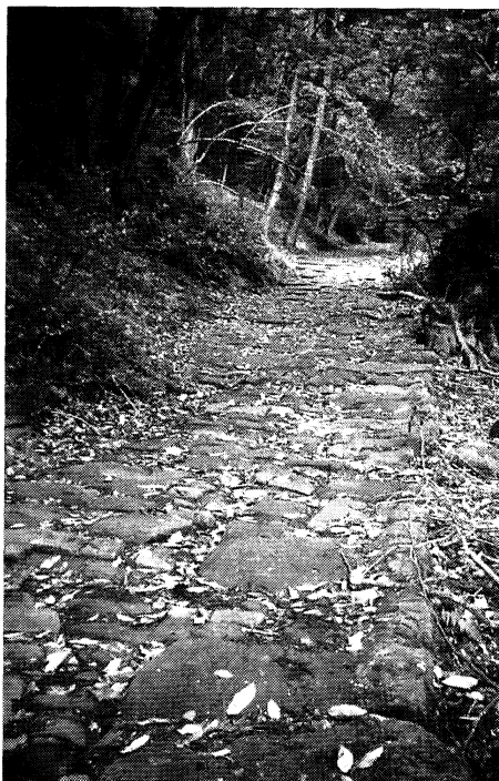
FIG. 2.—Calzada romana (Bárcena de Pie de Concha, Cantabria). En mitad de la imagen se observan largas losas transversales colocadas para el control de la escorrentía.
